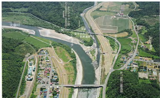
1. 調査地周辺航空写真 提供：旭川開発建設部名寄河川事務所
